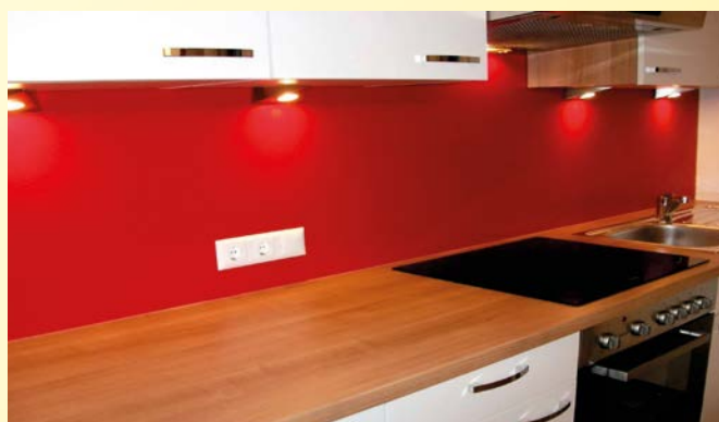
Küche: Wand, Decke, Küchenrückwand abwaschbar, fugenlos
