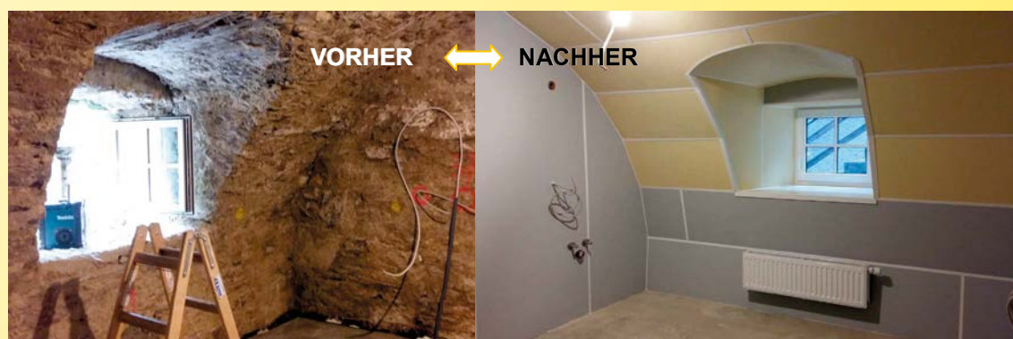
Kondensationsfeuchte wird saniert und vermieden durch Isotherm Ausbau-Paneele mit Dämmung Damit wurden Lebensmittel-Lagerraum und Gasthausküche im Altstadtbereich erst möglich!
